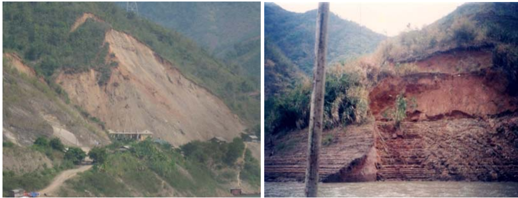
Hình 8. Ảnh trượt lở bờ hồ ở đầu cầu Tạ Khoa (ảnh Phạm Văn Hùng)
