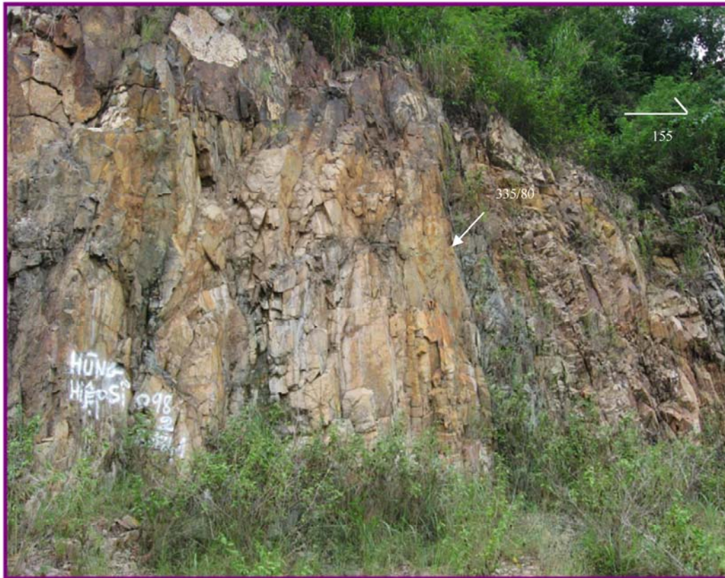
Hình 8. Khe nứt, mặt trượt đổ về TB trong đá biến chất tuổi Proterozoi ht. Khâm Đức, thể hiện sự tồn tại dập vỡ kiến tạo phương ĐB-TN tại xã Ea Trang, h. M'Đrắk, tỉnh Đắk Lắk (ảnh Lê Triều Việt, 2014)
