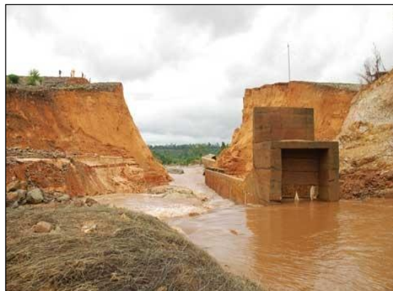
Ảnh 4. Lũ quét do vỡ đập thủy điện Ia Krel 2, xã Ia Dom, Đức Cơ, Gia Lai tháng 6/2013 (ảnh: Vietnamnet.vn)
