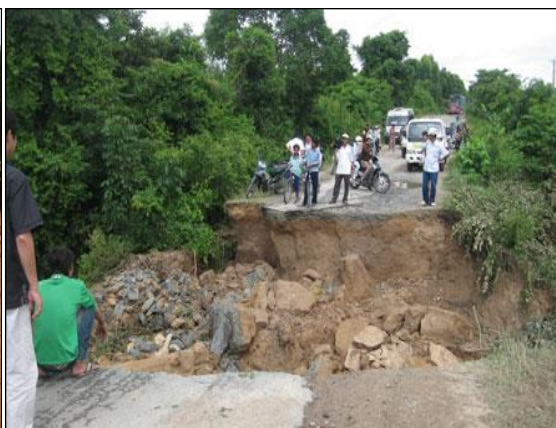
Ảnh 2. Lũ quét cuốn trôi gần 20 m QL25 tại xã Chư Ngọc, Krông Pa, Gia Lai tháng 09/2011 (ảnh: baogialai.vn)
