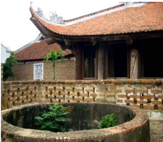
Hình 27. Đá ong được dùng để xây nhà ở, đền chùa ở làng cổ Đường Lâm, Sơn Tây (ảnh Nguyễn Thị Thanh Hải)
