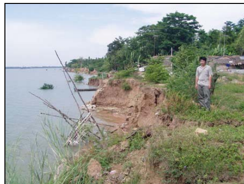
Hình 5. Xói lở tại đầu cù lao Long Khánh (2009)
