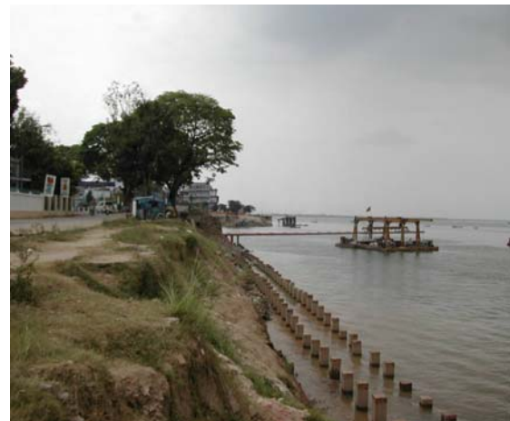
Hình 9. Xây dựng bờ kè tại bờ sông Tân Châu
