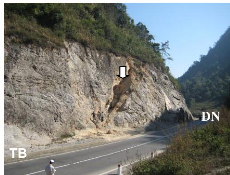
Hình 10. Đứt gãy phương ĐB-TN cắt từ chân lên đỉnh của sườn dốc tại điểm Lóng Luông với bề ngang phá hủy khoảng 1,5-2m. Mũi tên chỉ vị trí của đứt gãy
