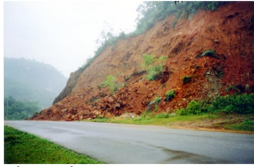
Ảnh 10. Điểm TLS4, trong vỏ phong hóa đá phiến sét, kéo dọc theo đường trên 100m
