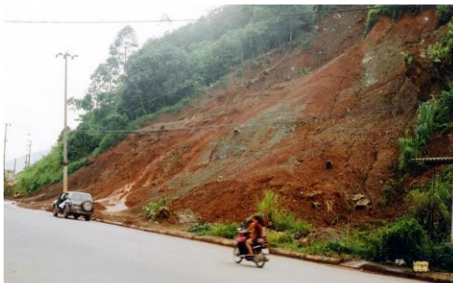
Ảnh 12. Điểm TLS5, trượt trong vỏ phong hóa đá phiến sét, kéo dài 100 m theo đường
