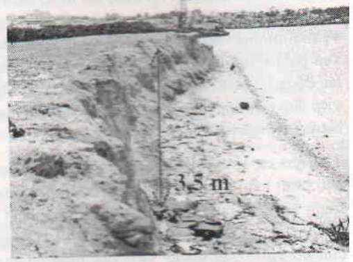
Ảnh 2. Xói lở bờ biển ở phường Đức Thuận
