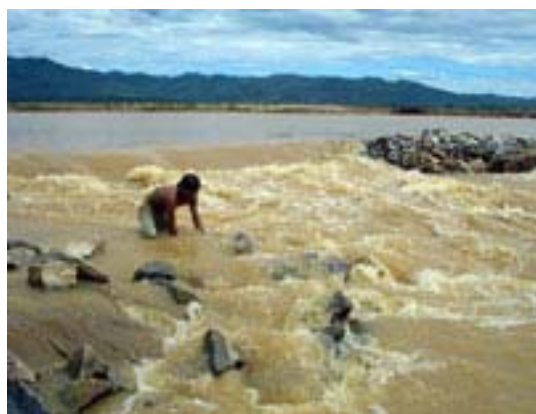
Dòng lũ cuốn trôi tuyến kè (a)
