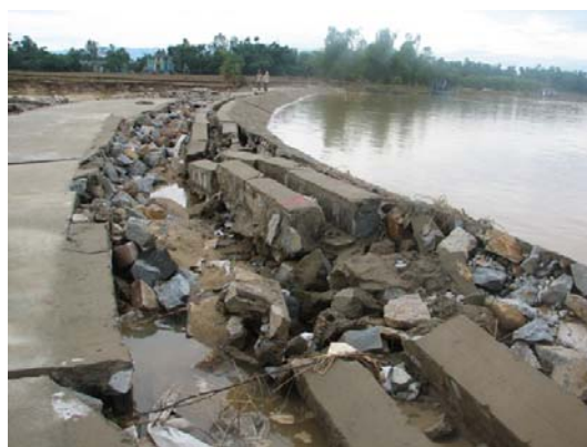
Kết cấu kè bị phá hoại sau lũ (b)
