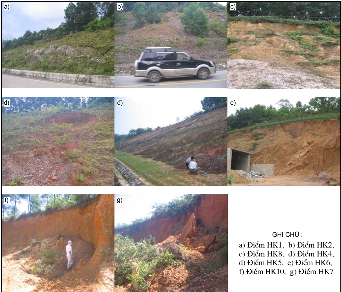
Ảnh 2. Các điểm trượt lở taluy phải và trái (hướng bắc-nam) đường HCM đoạn qua tỉnh Hà Tĩnh (ảnh : Nguyễn Tiến Hải, 2009)
