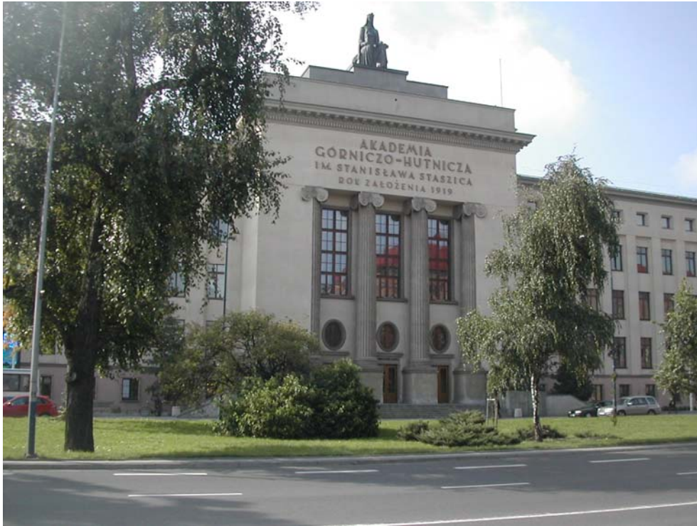
Ảnh 2. Tòa nhà A-0 của Khoa Địa chất, Địa vật lý và Bảo vệ Môi trường thuộc ĐH Khoa học và Công nghệ AGH nơi đăng cai Đại hội IAH 2010
