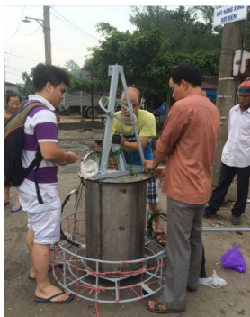
a. Lắp thiết bị trên cảng
