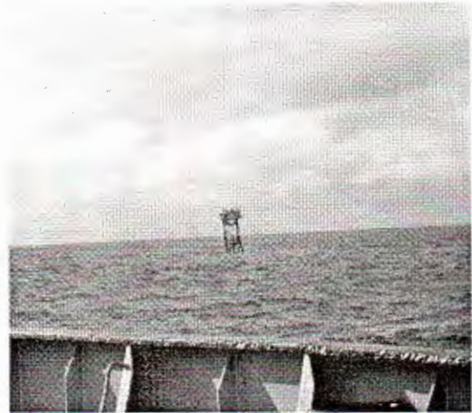
Hình 2. Công trình DKI-14 bị nghiêng
