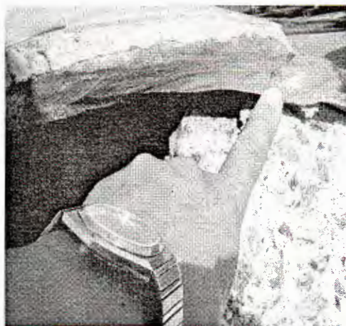
Hình 13. Ống gia cường gãy tại DKI/17
