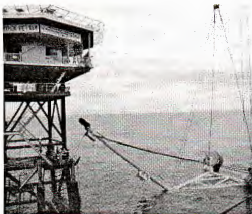
Hình 11. Cầu lắp các kết cấu gia công
