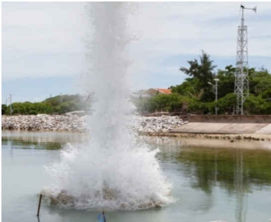
Hình 9. Các thử nghiệm nổ đều diễn ra thành công, an toàn
