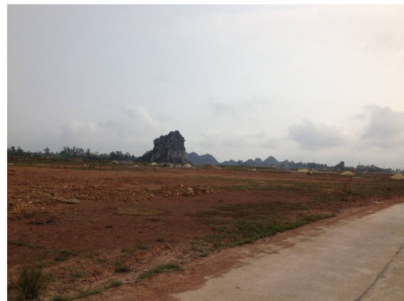
Hình 6. San lấp mặt bằng tại xã Hà An, huyện Yên Hưng [Nguồn: Nguyễn Văn Thảo, 2011]
