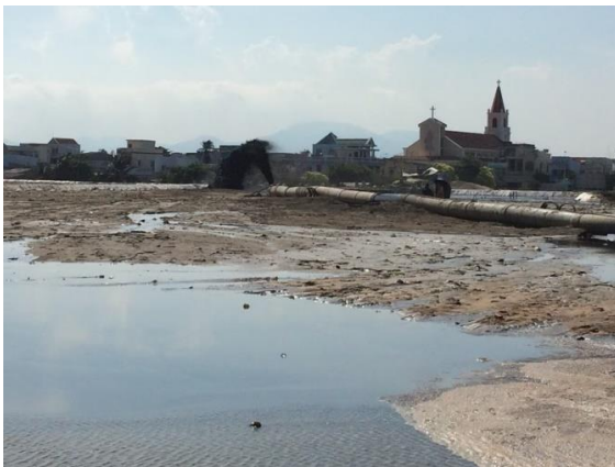
Hình 2. Cát nạo vét luồng được sử dụng để san lấp thành khu lấn biển ở La Gi
