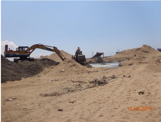
Hình 12. Đang nạo vét luồng ở Phan Rí Cửa
