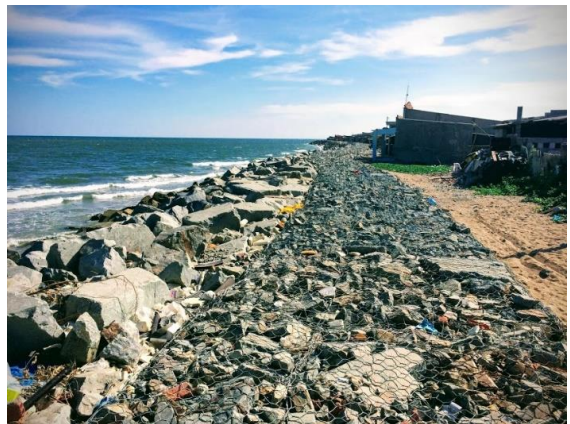
Hình 4. Đoạn kè bờ phía nam cửa La Gi
