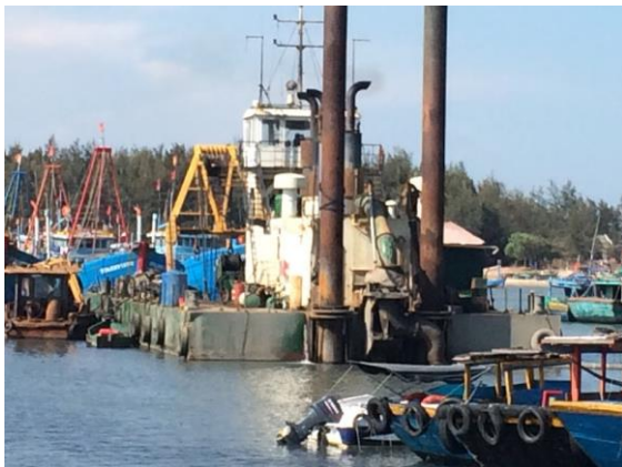
Hình 3. Đang nạo vét luồng tận thu cát phục vụ khu lấn biển ở La Gi
