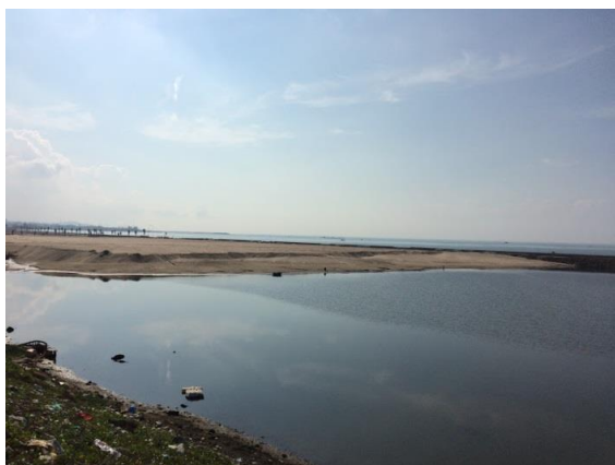
Hình 8. Khu vực cát được bơm vào để lấp các ao còn sót lại ở bên trong kè (khu vực lấn biển)
