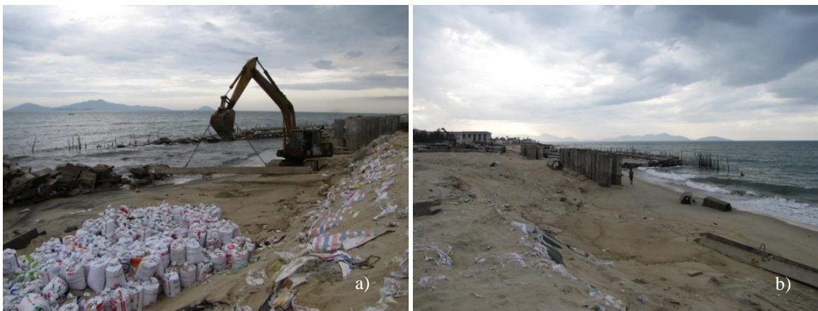
Hình 9. Công trình đang thi công để bảo vệ bờ ở phường Cửa Đại [Ảnh: 5/2012]
