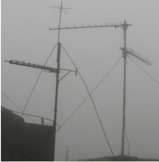
(a) Ăng ten thu - phát sóng vô tuyến tần số FM tại Trạm trung chuyển Tam Đảo
