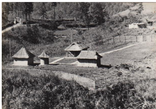
Ảnh 2. Bốn nhà đo từ trường Trái đất gồm: (1) Đo trực tiếp các đại lượng từ trường; (2) Thiết bị điều khiển bộ phận tự ghi; (3) Nhà đặt bộ phận tự ghi từ trường Trái đất; (4) Nhà dựng thiết bị nghe thời gian quốc tế
