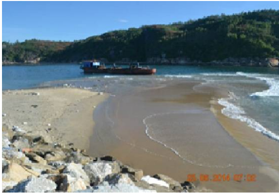
Hình 11. Cồn cát phía trong đầu kè chắn sóng nổi lên khỏi mặt nước (chụp ngày 25/6/2014)
