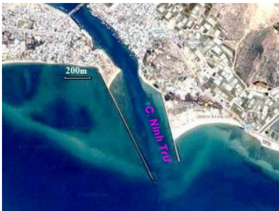
Hình 6. Kè chắn cát hai bên cửa Ninh Chữ
